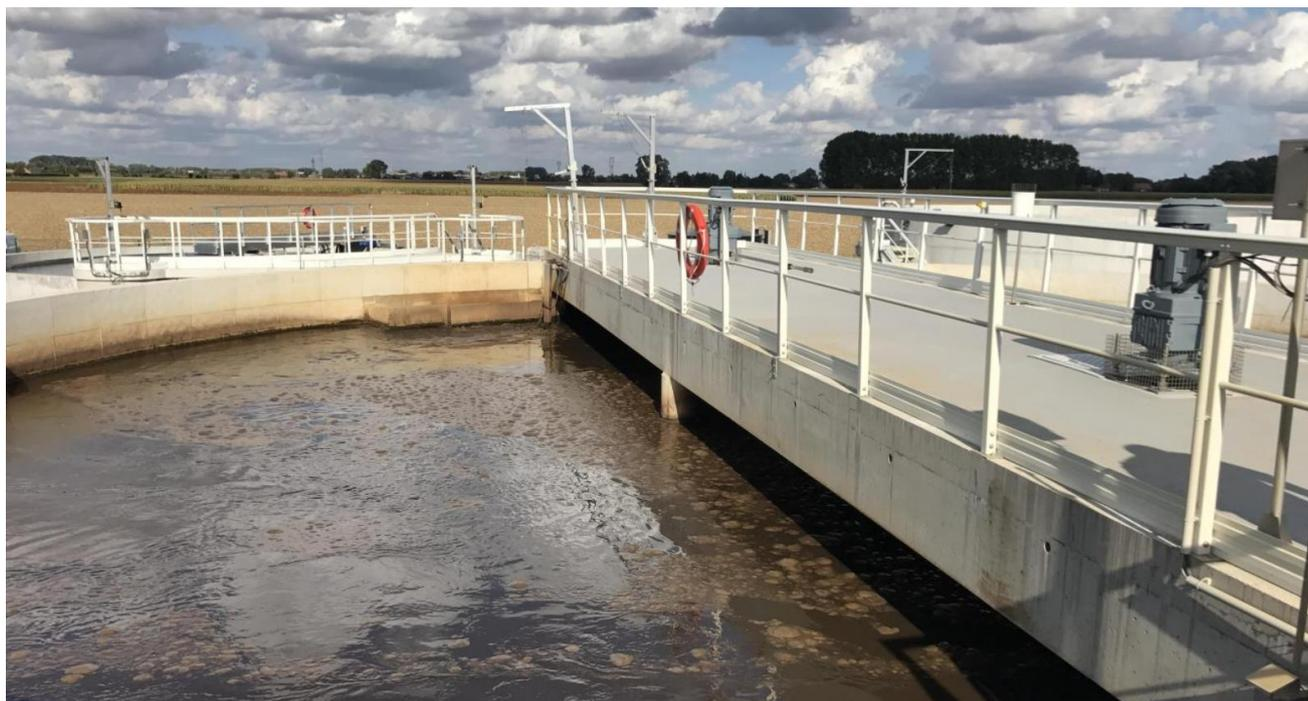
La nouvelle station d'épuration intercommunale de la rue Morienne est dimensionnée pour une capacité de traitement de 4 800 équivalent habitants. Elle doit permettre de traiter les effluents domestiques situés en zone d'assainissement collectif des communes de Fleurbaix, Sailly-sur-la-Lys Est et le hameau de la Croix-du-Bac.
