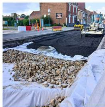
Travaux de réfection en profondeur d'une partie de la rue de la Lys (Été)
